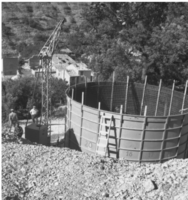
Construction du bassin de La Buisnière, vers 1960
