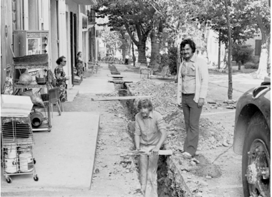
Travaux du tout-à-l'égout boulevard de la République
