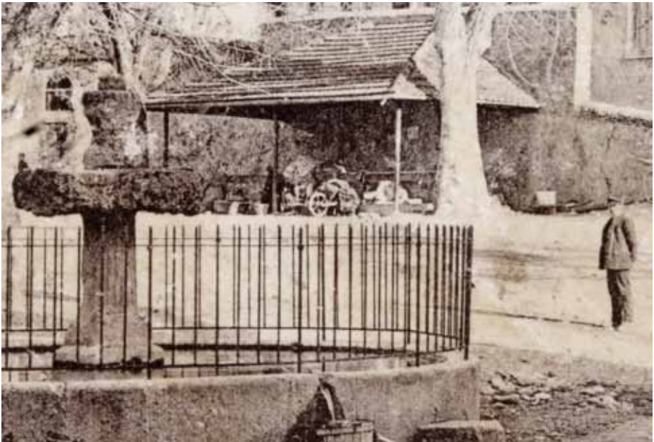
Le premier W-C public se trouvait à côté de ce lavoir
