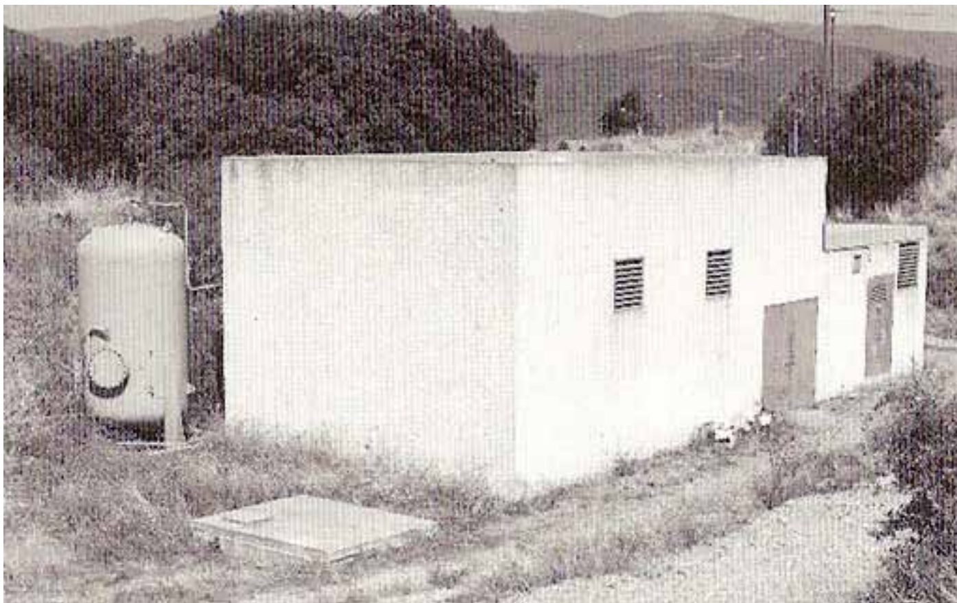
Station pompage S3-Paillerols
