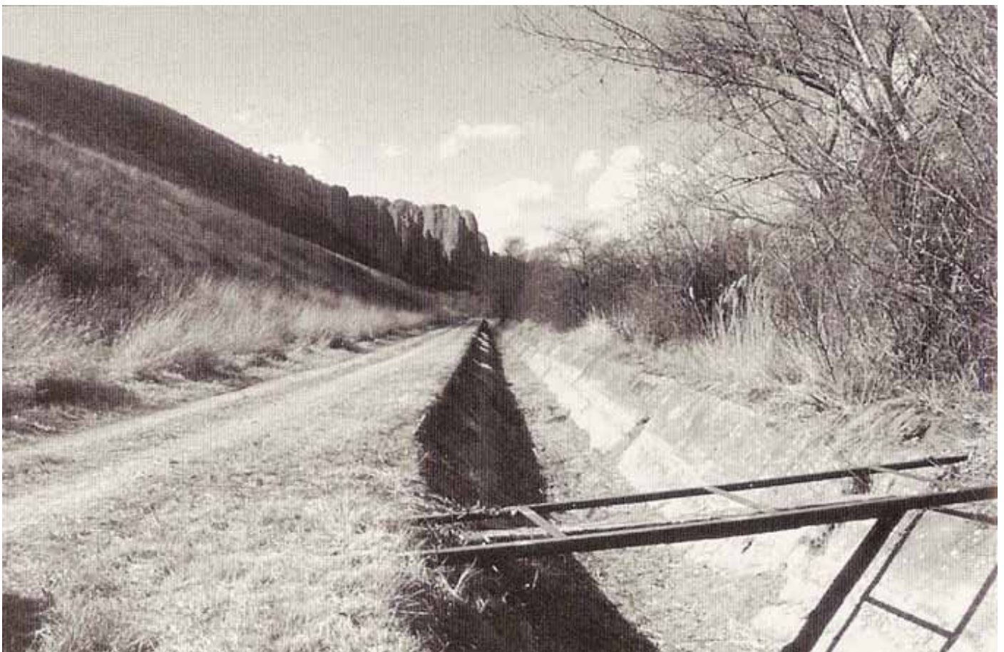
Canal du Moulin des Mées - Tronçon bétonné
